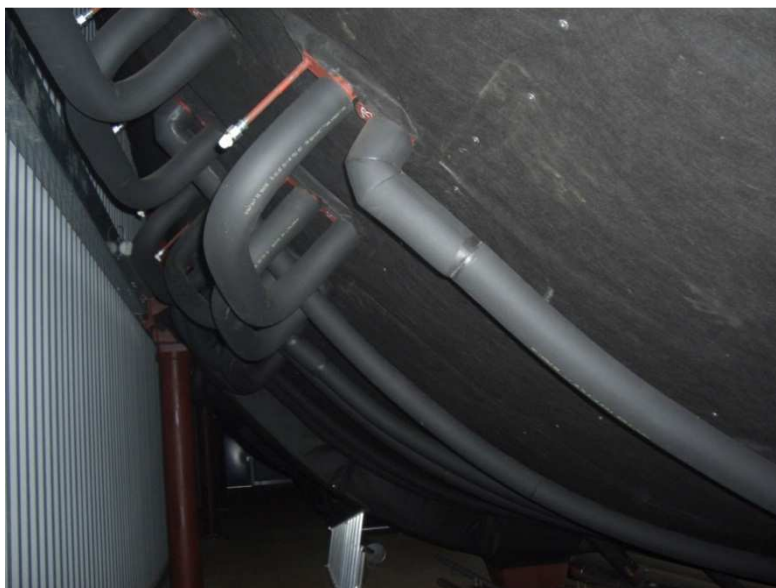
Figura 29 – Vista della zona di inserzione delle tubazioni di mandata e ritorno dell'acqua calda alle lance riscaldanti interne
