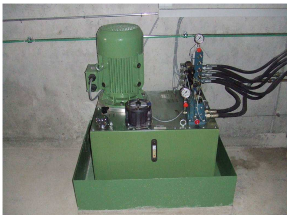
Figura 23 – Immagine della centrale idraulica di azionamento della pompa a pistone
