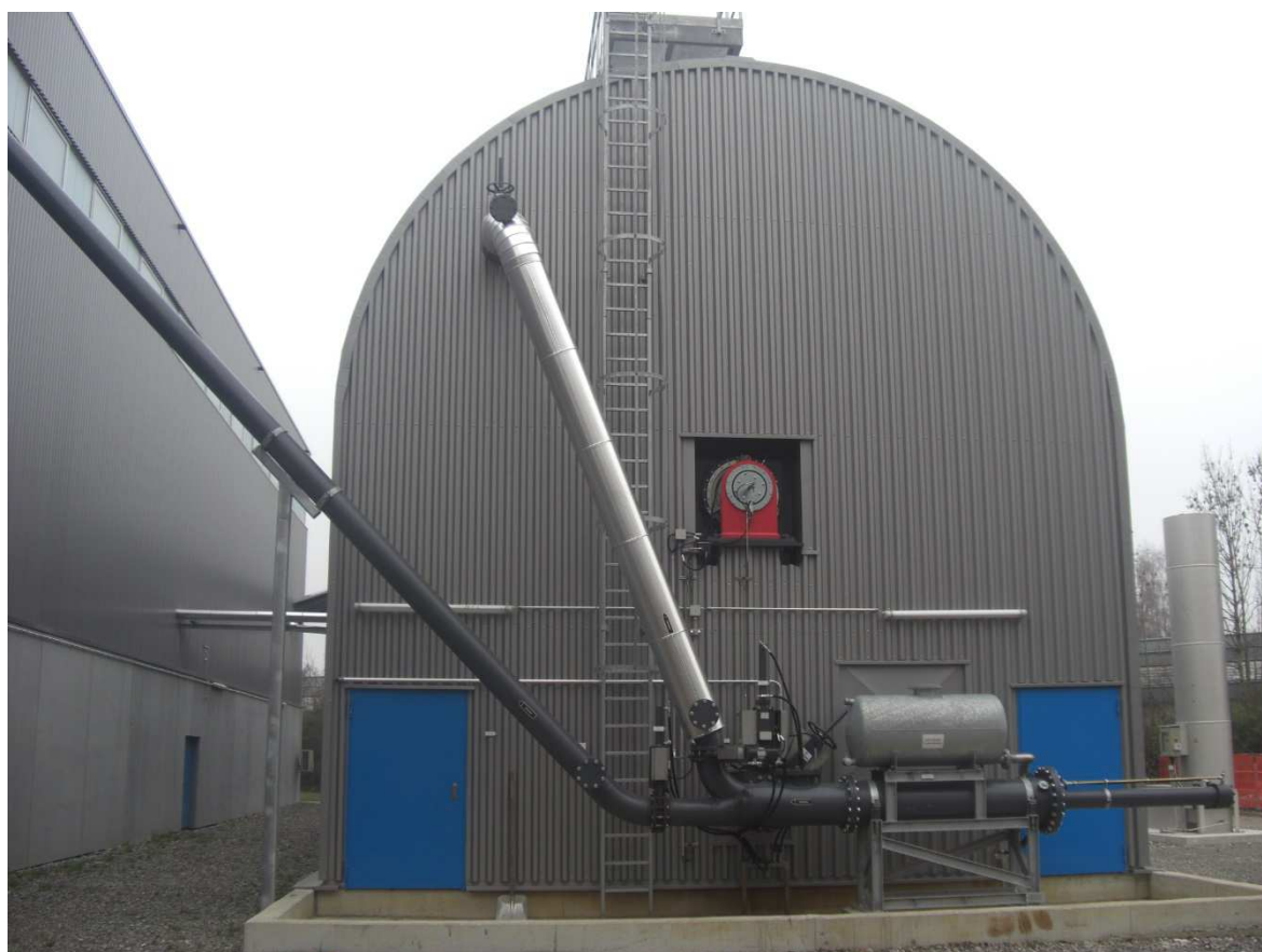
Figura 21 – vista dal lato di estrazione del digestato, pompa a pistone
