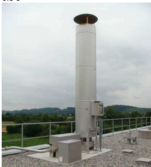
Figura 25 – Immagine della TORCIA posizionata sulla copertura del digestore
